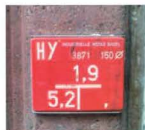
Hinweisschild Unterflurhydrant (gibt Position des Hydranten an)
